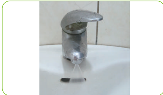
省水器材更換(洗手台加裝省水器)
