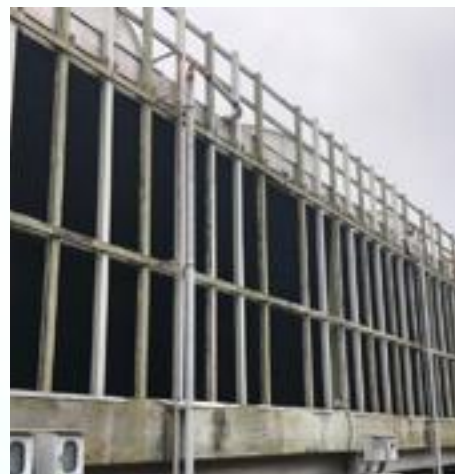
冷卻水塔更換鰭片及整修
