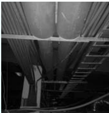
辦公室及走道冰水管汰換 PE 保溫
