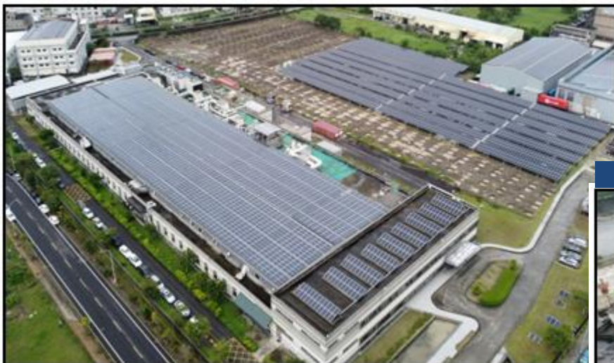
宜蘭廠屋頂型太陽能案場
