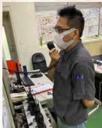
△消防監控系統 / 廣播系統操作
