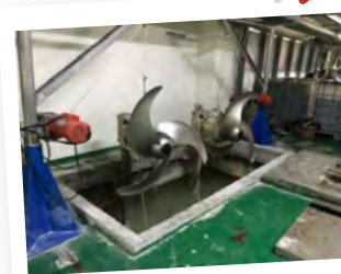
改善後-更換攪拌機扇葉
