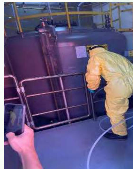
▲ 災後處理，使用泵浦將漏酸抽至噸桶並進行現場除污
