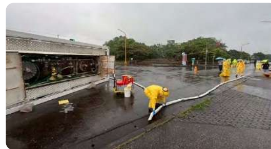
▲ 圍堵組進行排水溝孔圍堵
