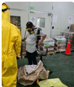
4. 搶救班進入熱區：(1) 操作機台 - 停止排酸 (止洩)、(2) 於洩漏處鋪設吸液棉 (索)、(3) 洩漏處無殘液後，將吸液棉 (索) 放入有害廢棄物處理袋
