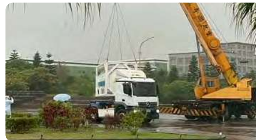
▲ 移槽完成槽體上拖車後狀況解除
