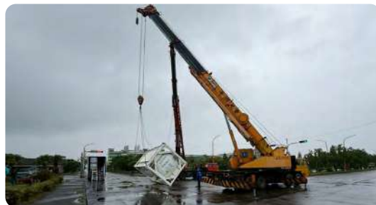
▲ 移槽組進行吊掛作業
